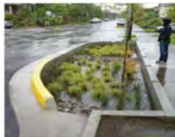
Green Street 道路沿いの緑地の縁石を一部空けて、緑地内に雨水を流し込む仕組みになっている。
