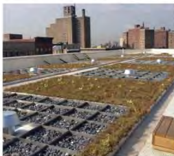
屋上緑化面積に応じた固定資産 減税措置が図られている。
