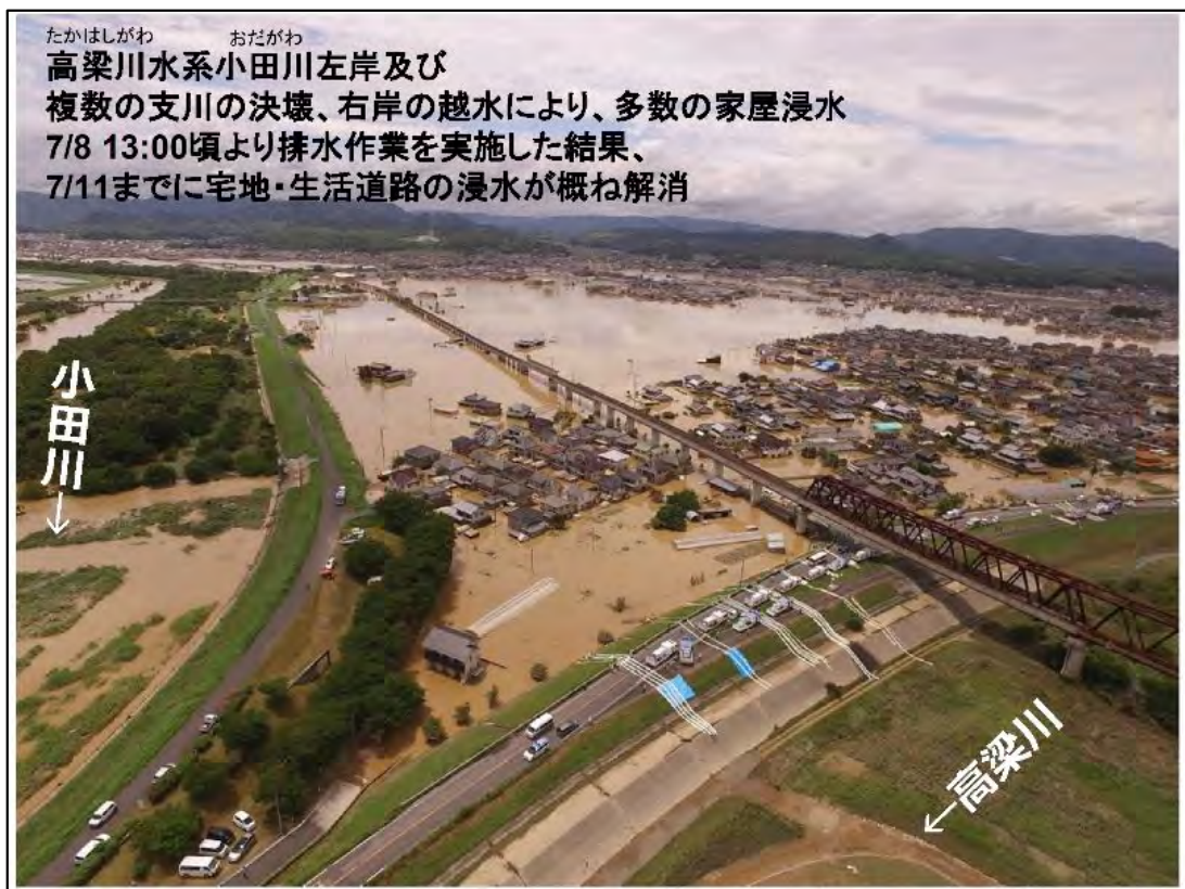
写真 1.1 平成 30 年 7 月豪雨（西日本豪雨）の被害状況
