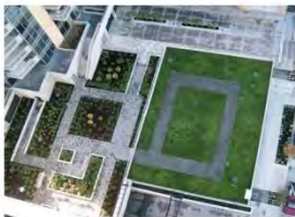
高層ビルの屋上緑化 雨水管理だけでなく、屋根を保護する効果なども期待されている。
