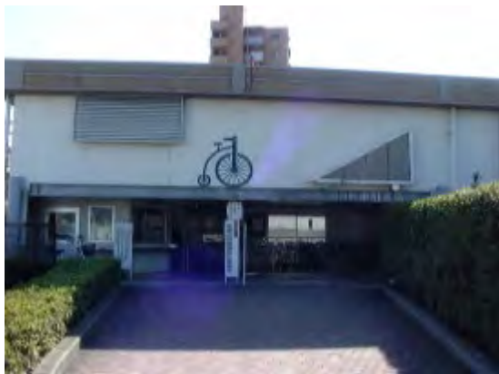
JR 安城駅北口自転車駐車場
