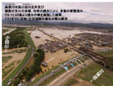
西日本豪雨の被害状況（国土交通省公表資料）
