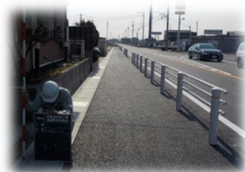
歩道に整備した透水性舗装
