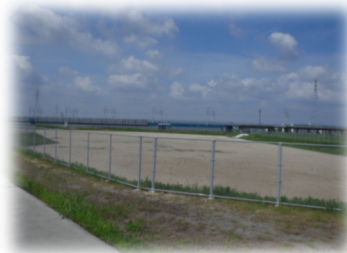
鹿乗川遊水地（下池）
