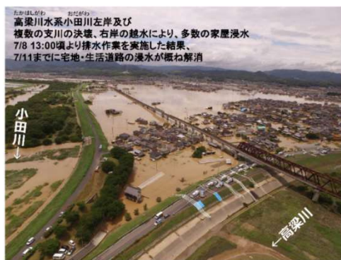
西日本豪雨の被害状況（国土交通省公表資料）
