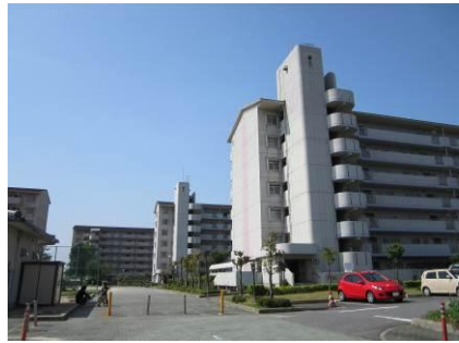
16棟が立ち並ぶ県営古井住宅
