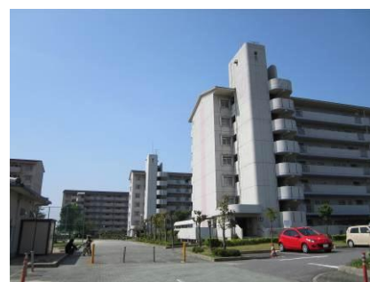
16棟が立ち並ぶ県営古井住宅
