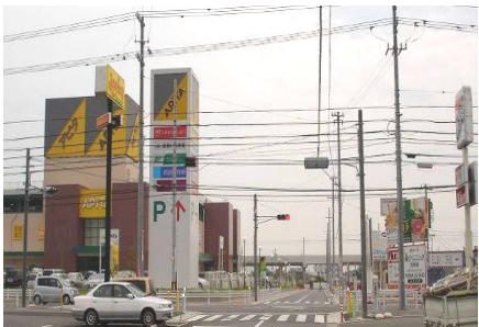
名鉄高架と新しい店舗が立ち並ぶ駅前
