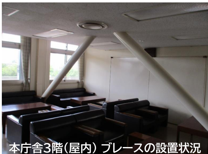
本庁舎3階(屋外) ブレースの設置状況
