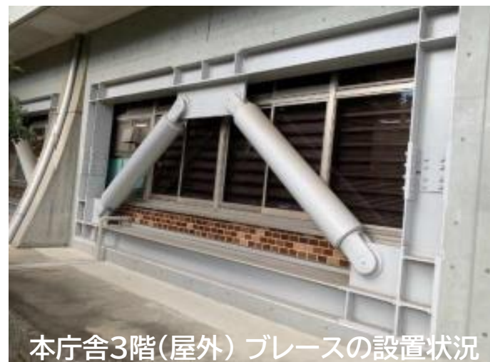
本庁舎3階(屋内) ブレースの設置状況
