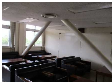
屋内ブレースの設置状況(本庁舎)
