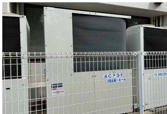
【ロビー空調設備更新修繕(室外機)】
