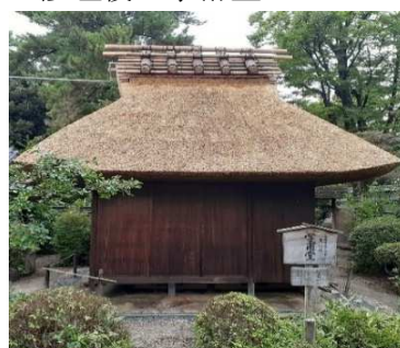
<修理後の学甫堂>
