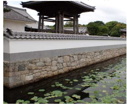
<修理された石垣と築地塀>
