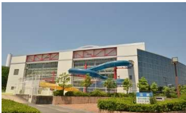
【安城市レジャープール 全景】
