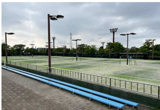
【総合運動公園テニスコート修繕】
