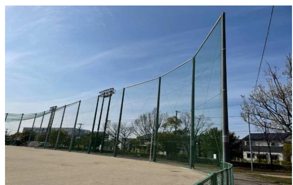
【和泉公園グラウンド及び防球ネット改修工事】
