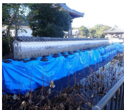
<石垣を大型土のうで保護>
