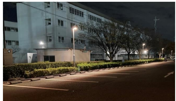
【照明設備更新工事(第1駐車場)】
