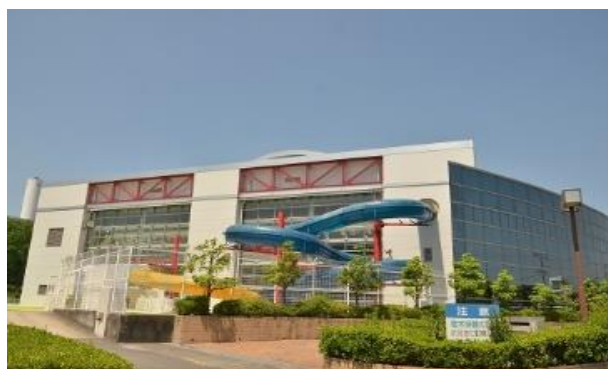
【安城市レジャープール 全景】
