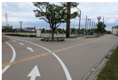
<総合運動公園園路改修>
