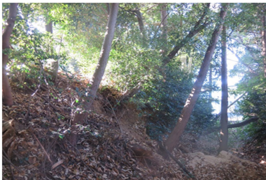
土塁き損が懸念される傾斜木
