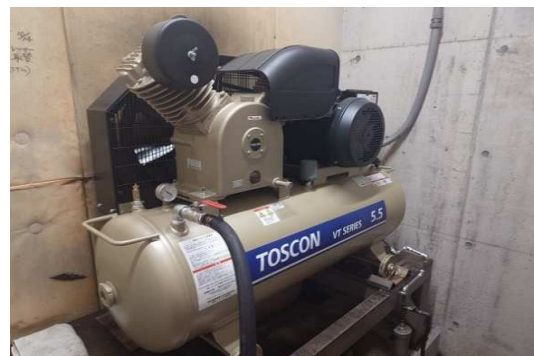
【造波コンプレッサー取替修繕】
