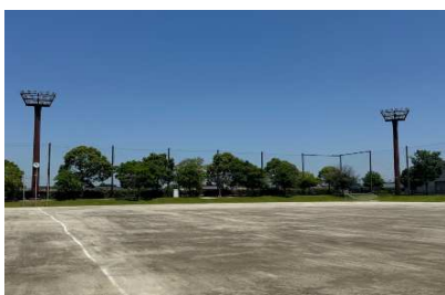
<多目的グラウンド夜間照明>
