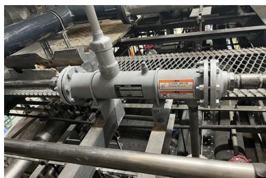
【熱交換器取替修繕】
