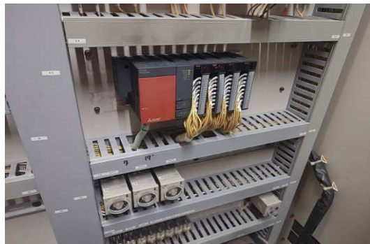
【造波装置制御機器取替修繕】
