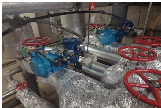
【蒸気供給圧力制御弁ほか更新修繕】
