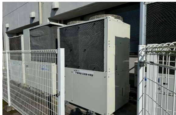
【事務室系統空調設備更新修繕(室外機)】
