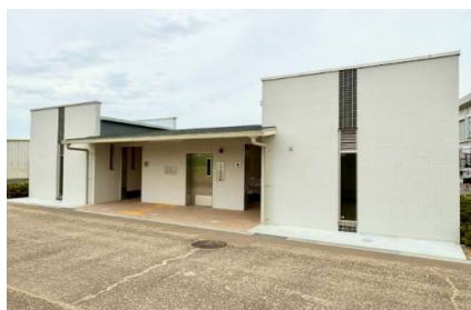
【屋外トイレ(建替え工事)】
