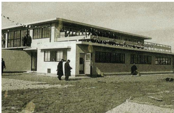
中部浄水場（現中部配水場）昭和30年頃
