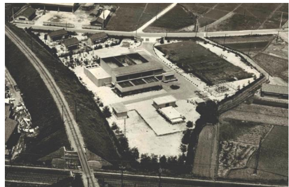
中部浄水場（現中部配水場）昭和40年
