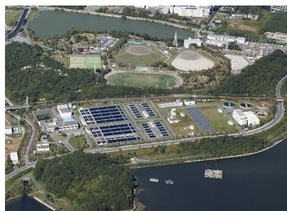
愛知県尾張東部浄水場（日進市）
