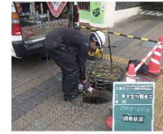
(左) 管口テレビカメラで点検をしている様子
