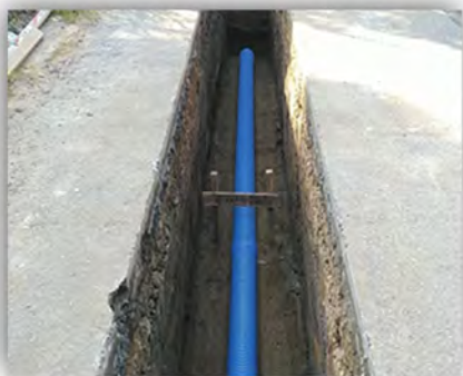
下水道管を埋めている様子
