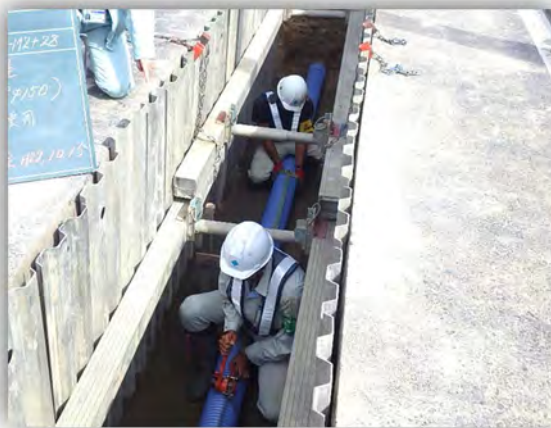
下水道工事の様子
