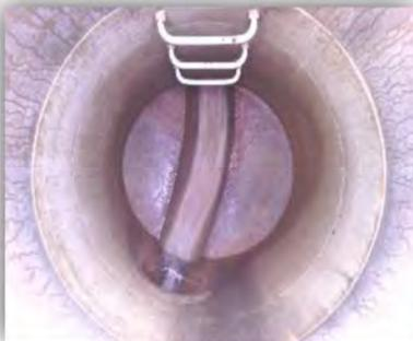
マンホールは普段見ることのできない下水道管を点検するために、約100m間隔で設置しています。
