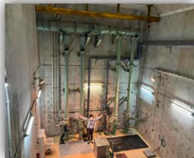
下水道管は自然勾配で汚水を流します。そのため下流になればなるほど深くなります。そこで、汚水をポンプでくみ上げ、深さを調整するマンホールポンプや中継ポンプ場が各所に整備されています。
