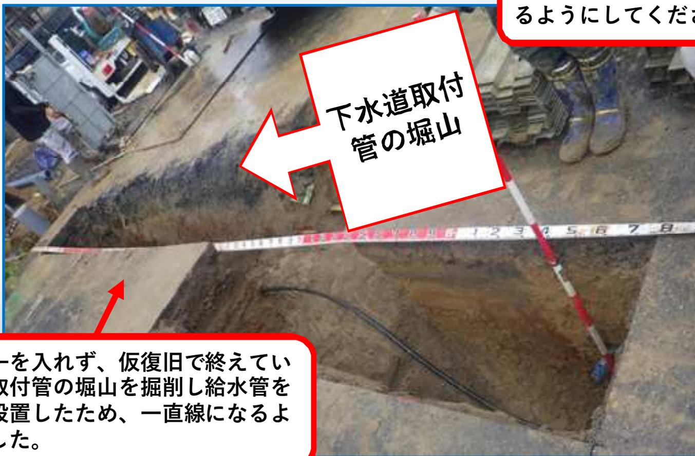
改めてカッターを入れず、仮復旧で終えていた下水道取付管の堀山を掘削し給水管を曲線的に設置したため、一直線になるよう再施工した。
