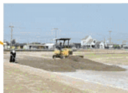
道路築造と宅地造成
