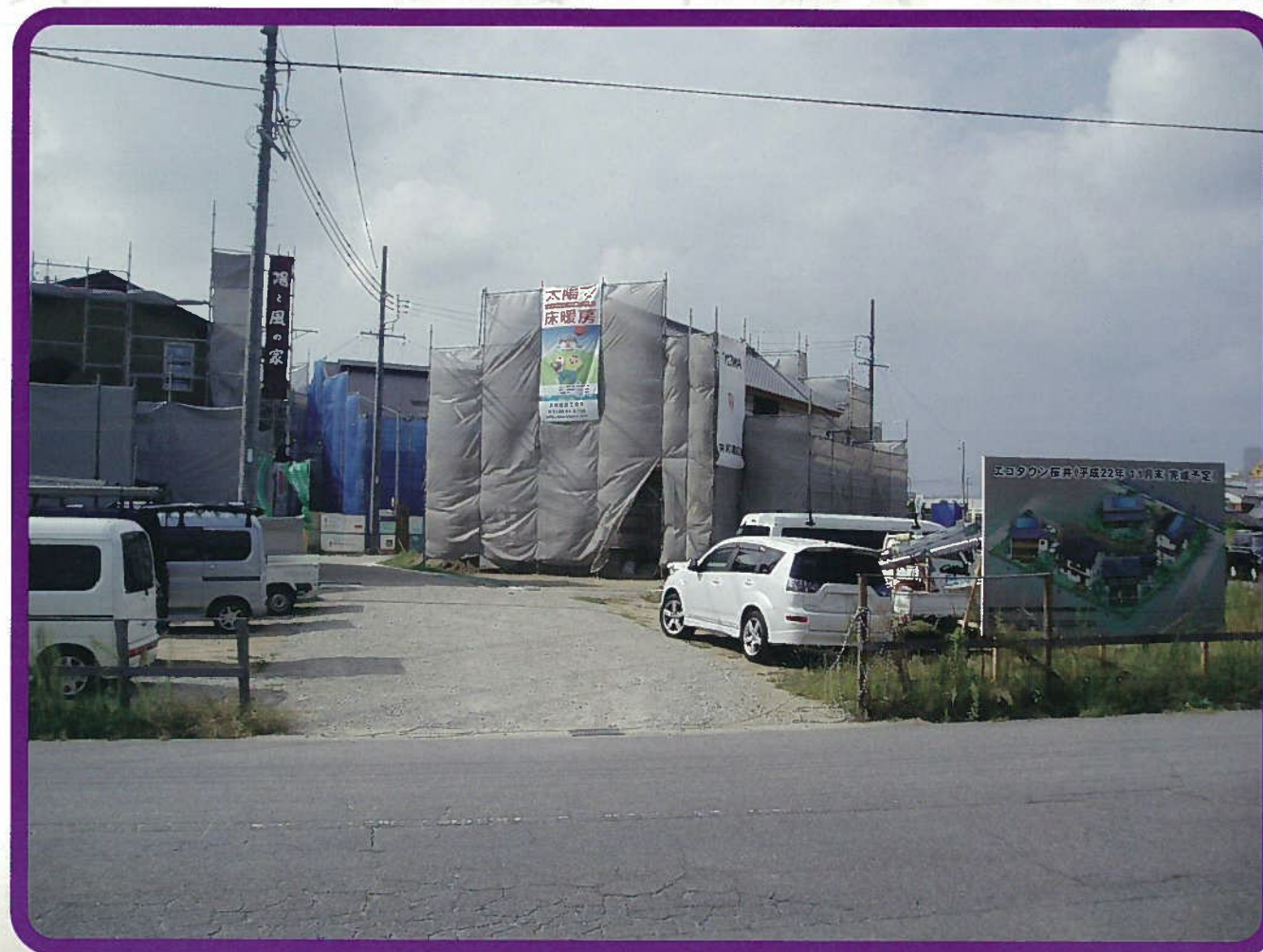
エコタウン桜井(旧城山保育園)の建設工事をしています
