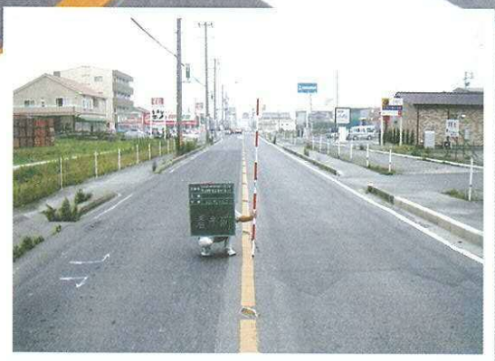
▲ 整備前の様子(平成19年頃)
