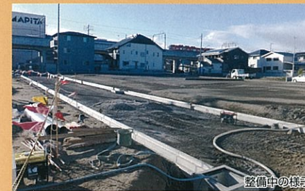
整備中の様子
