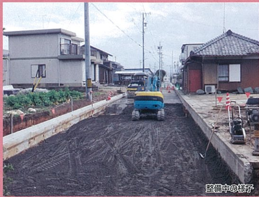
整備中の様子
