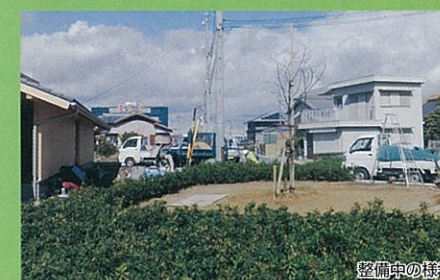
整備中の様子
