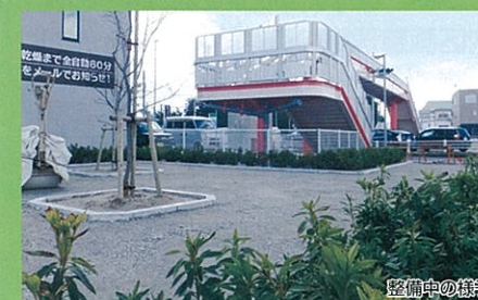
整備中の様子
