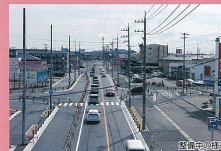
整備中の様子
