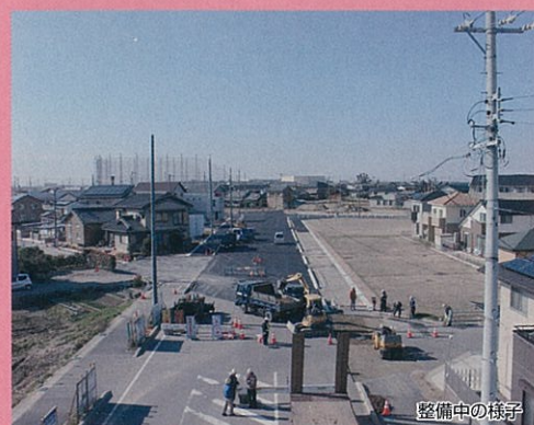
整備中の様子
