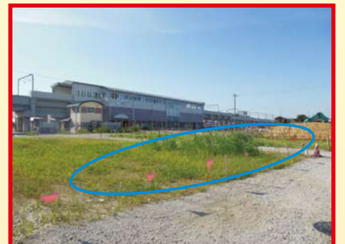
2号駅前広場整備予定地
