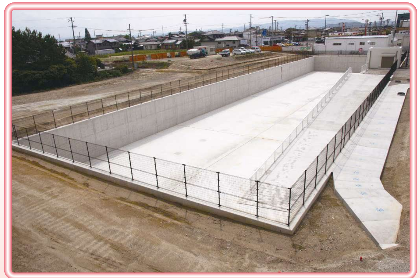
2号調整池が完成しました。
