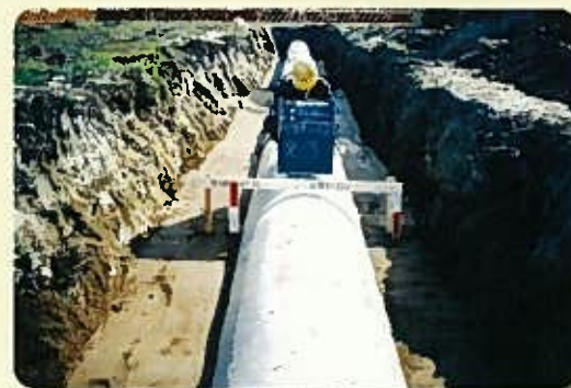
地中に埋まっている管(西徳用水代替工事の時)
