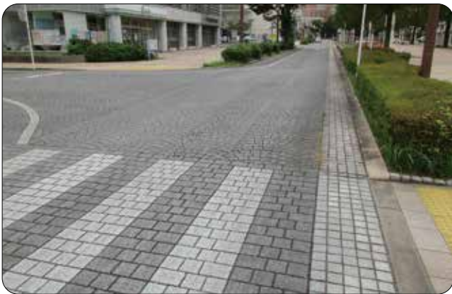
ブロック状模様の車道舗装「アクト通り」
