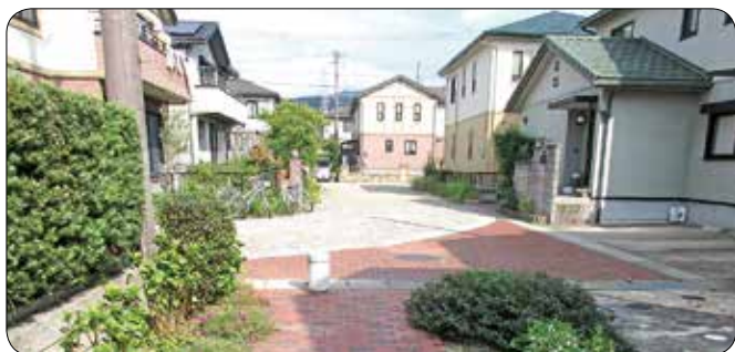
歩行者専用道路と区画道路の 交差点の舗装の工夫(幸田町桜坂)
