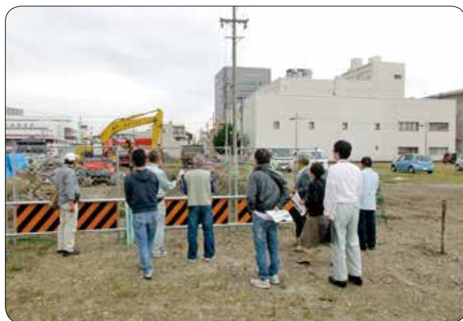
既設水路の撤去工事見学
