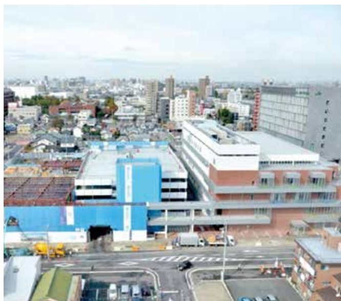
全体の建設状況(11月15日撮影)
