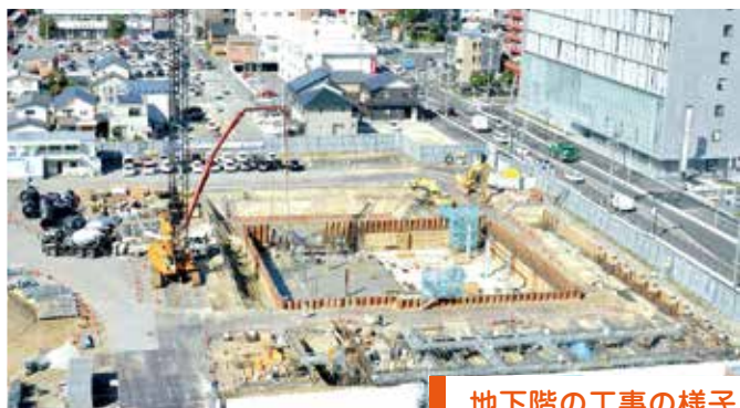
地下階の工事の様子
