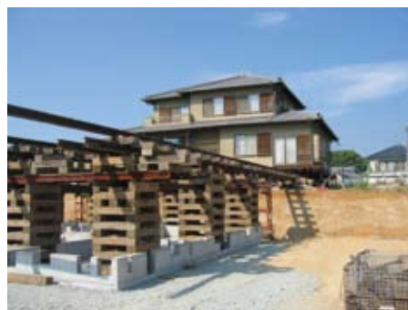
※曳家工事イメージ写真
