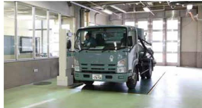
搬入し尿等計量装置
