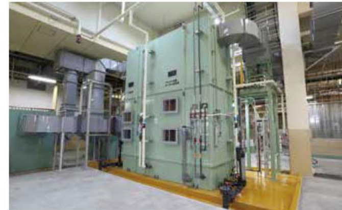
■水洗浄塔・アルカリ次亜カーボン洗浄塔
