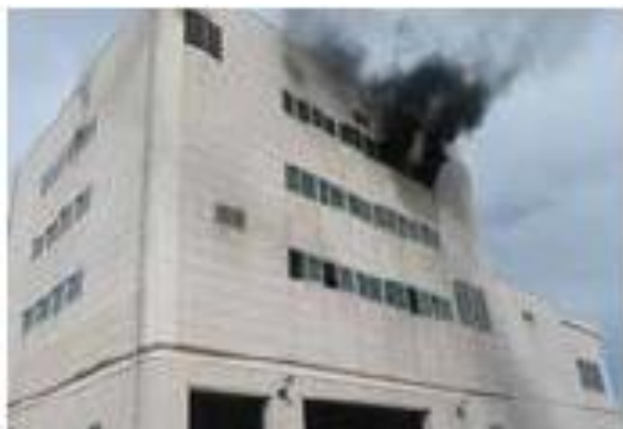
R3.10.21 リサイクル プラザ火災
