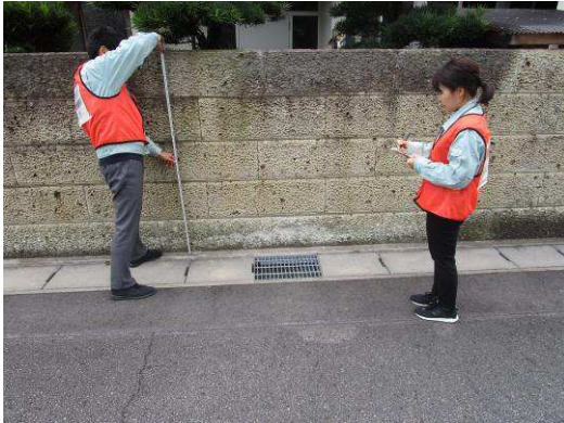
安全点検の様子
