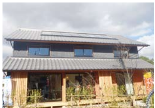
太陽熱高度利用システム設置住宅
