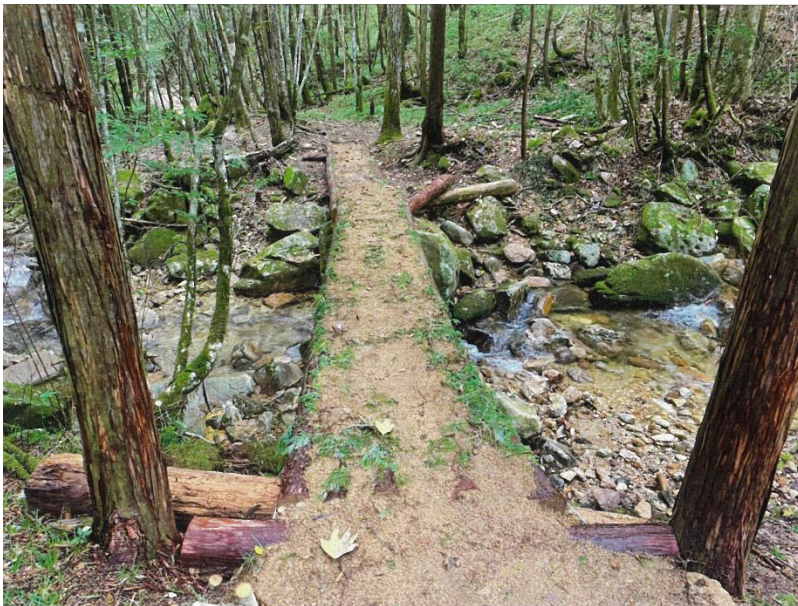
②水環境を良くする 【水源の森保全事業】 修繕をした木橋の様子
