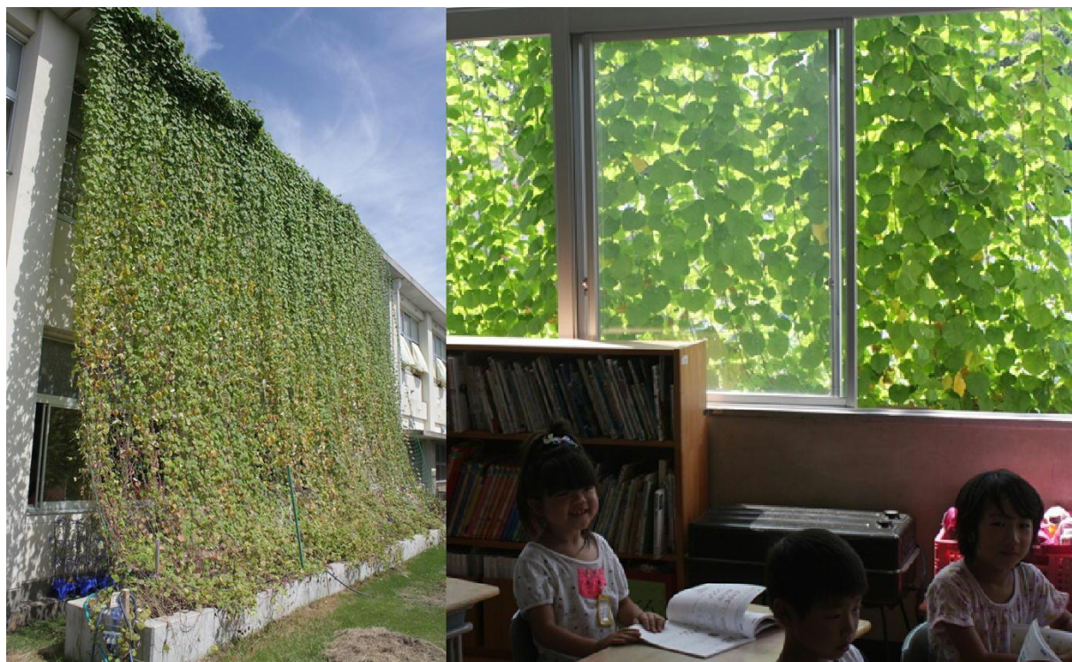
校舎屋上まで伸びたグリーンカーテンと葉陰になって涼しい教室内
