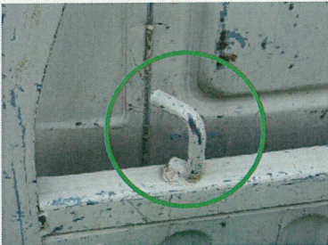
写真2：鳥居 ロープ等引っ掛けフック
