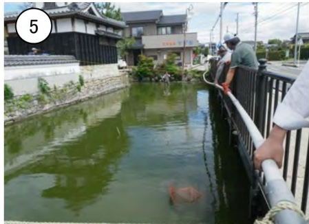
⑤北側内堀の道路側から 鼓樓側へ送水管を投入。
