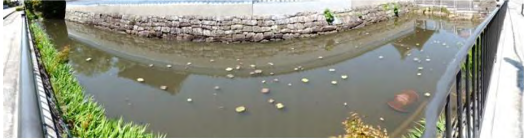
▲5月13日南側内堀 たくさんの浮き葉が出ています。今後も 見守ってください。
