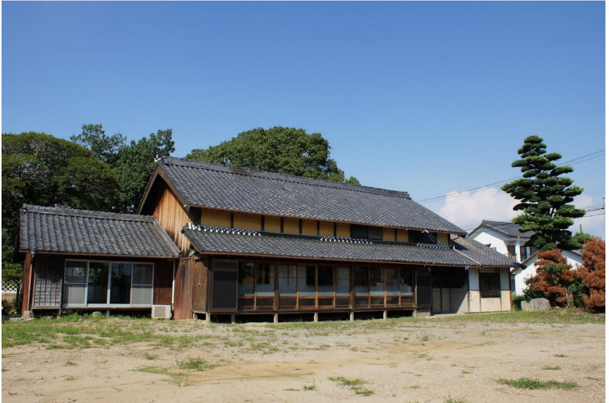
旧神谷家住宅主屋（外観）
