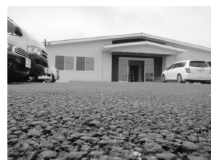
透水性舗装(施工後)
