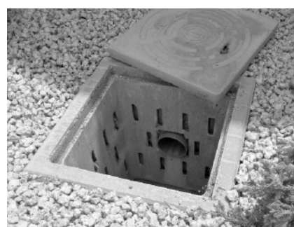
浸透マス(内部)
