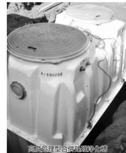
高度処理型合併処理浄化槽
