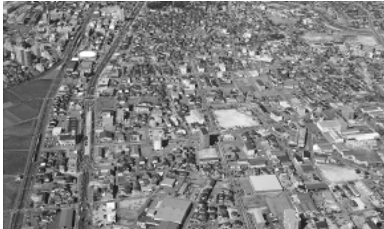
早期完了が望まれている北部土地区画整理事業
