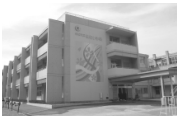
完成した桜町小学校校舎
