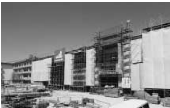
耐震構造に改築中の安城西中学校
