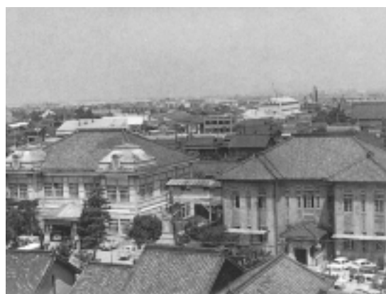
▲安城町農会館(右)と碧海郡農会館
