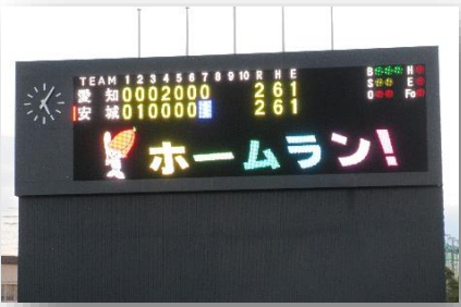
電光掲示板新設
