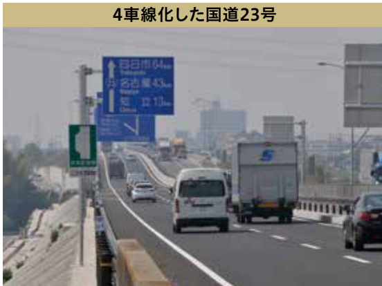
4車線化した国道23号
